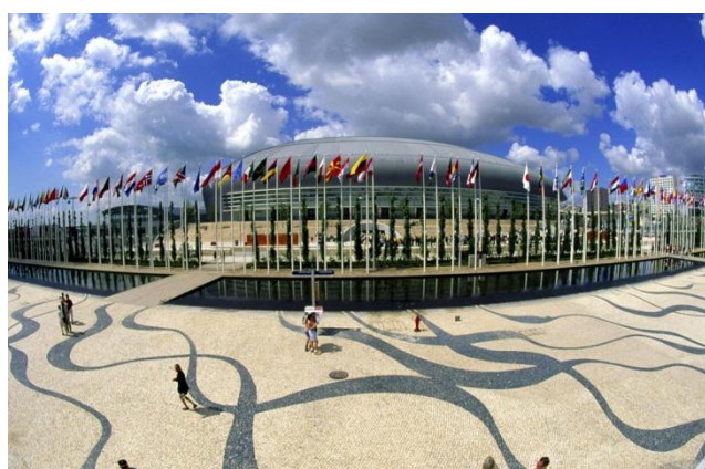
Figura 39 Expo 98 - Espaço público e equipamento na requalificação da cidade oriental
