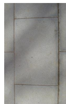
Figura 111 Detalhe da laje do pavimento
