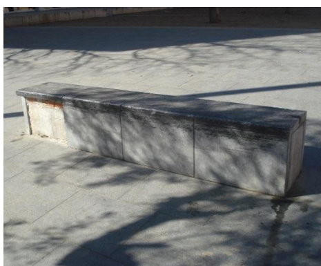
Figura 106 Um dos bancos da praça que revela o desgaste provocado pelo skateboarding
