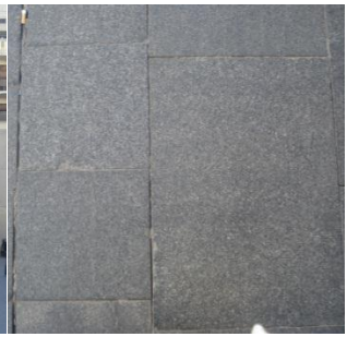
Figura 92 Vista próxima das lajes do pavimento
