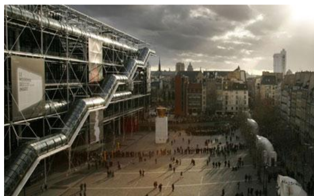
Figura 20 Centre Georges Pompidou - praça fronteiriça
